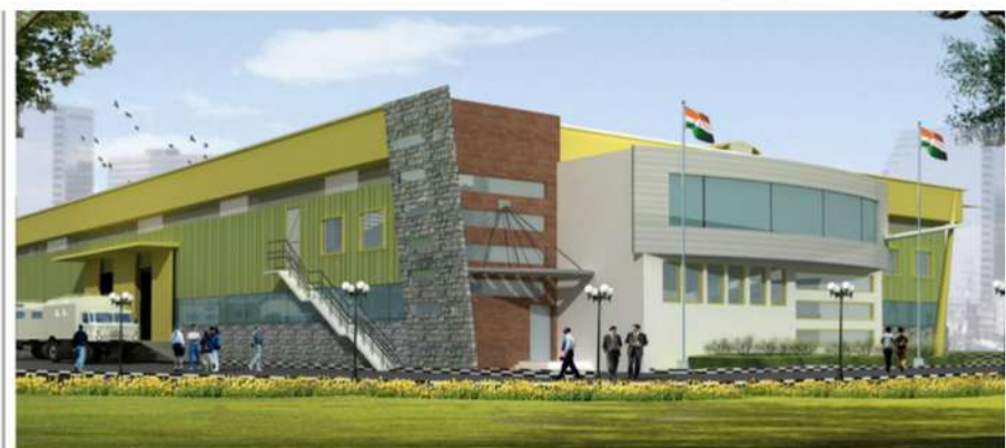
JST Stesalit Transformers Pvt. Ltd.,Baddi (HP)
